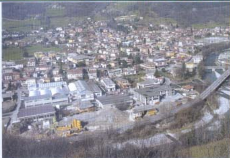
CMC ha sede a Colzate dove sorgono due diverse aree produttive
