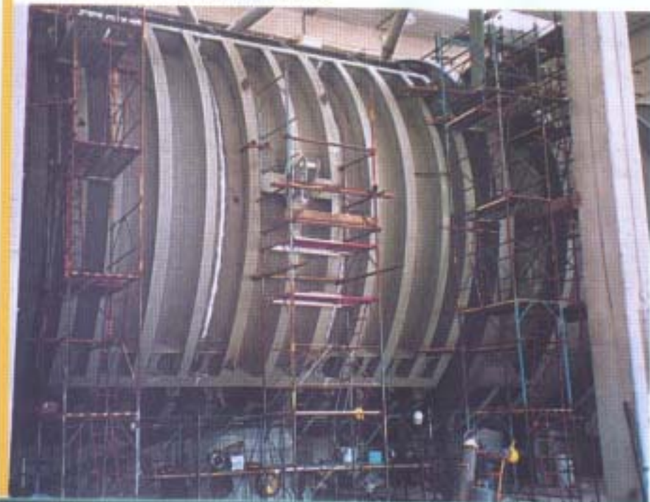
Il tamburo della galleria presenta un diametro di 8 m e contiene tre camere che hanno una sezione di prova con altezza di 2,5 m e larghezze diverse
